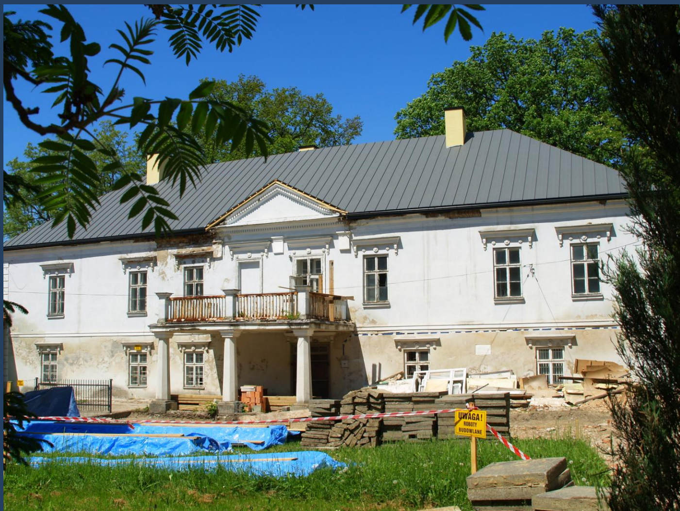
Trwa w dalszym ciągu remont dawnego Liceum Ogólnokształcącego – 20 maj 2013 r.
